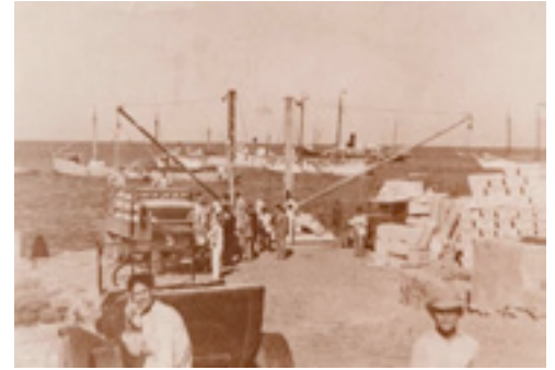
Antiguas instalaciones portuarias.- El viejo puerto de La Aldea y las infraestructuras destinadas a la pesca y a la estiva de la producción agrícola del municipio también forman parte del Parque Cultural Los Caserones como parte fundamental de los aprovechamientos económicos del territorio y su vinculación a la cultura de la comarca.
